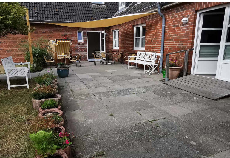
Nicht barrierefreie Außenanlage – Umbaumaßnahmen stehen an
