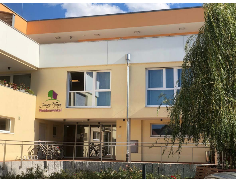
Blick auf das Gebäude der Wohngemeinschaft
